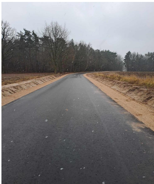
Fotografia. Droga gminna w miejscowości Suliszew
