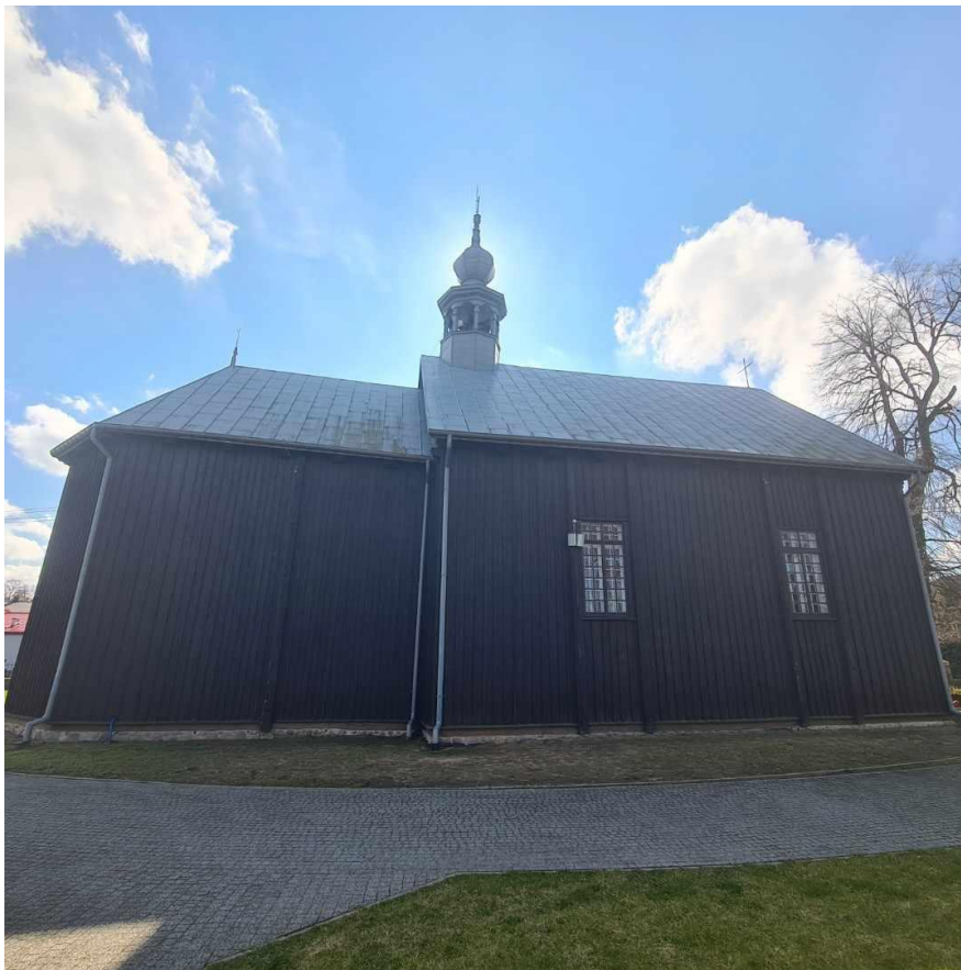
Fotografia. Ściany zewnętrzne drewnianego kościoła parafialnego w Starej Rawie.
