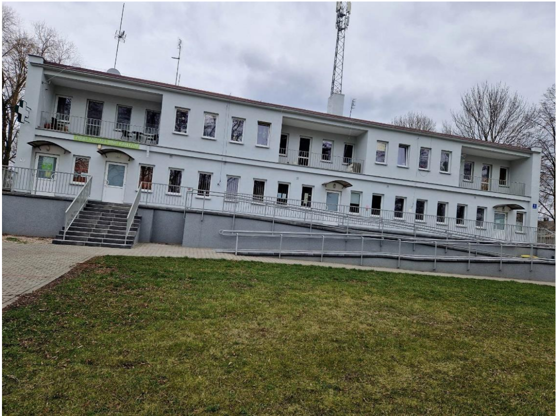
Fotografia Budynek Ośrodka Zdrowia w Nowym Kawęczynie
