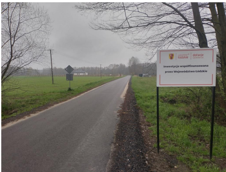
Fotografia. Droga gminna w miejscowości Suliszew
