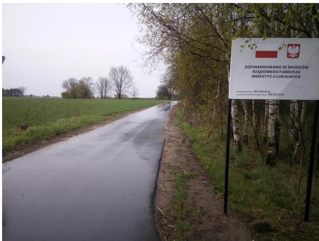
Fotografia. Droga gminna w miejscowości Nowa Trzcianna
