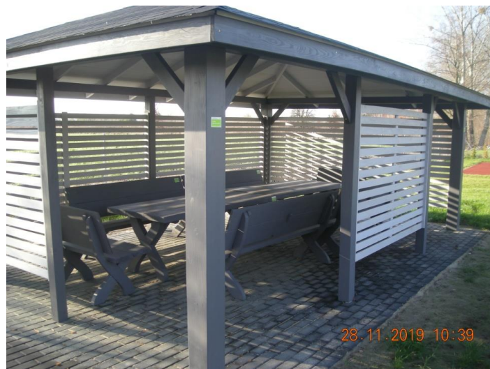
Zdjęcie. Zagospodarowanie terenu w sołectwie Rawiczów poprzez budowę wiejskiej altany celem rozwoju integracji społecznej”
