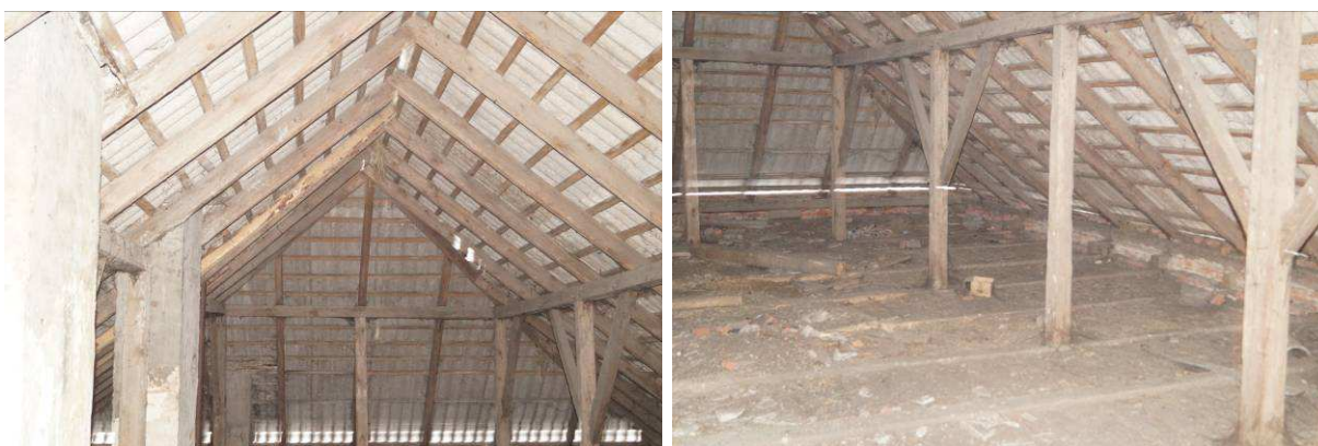
Konstrukcja więźby dachowej
