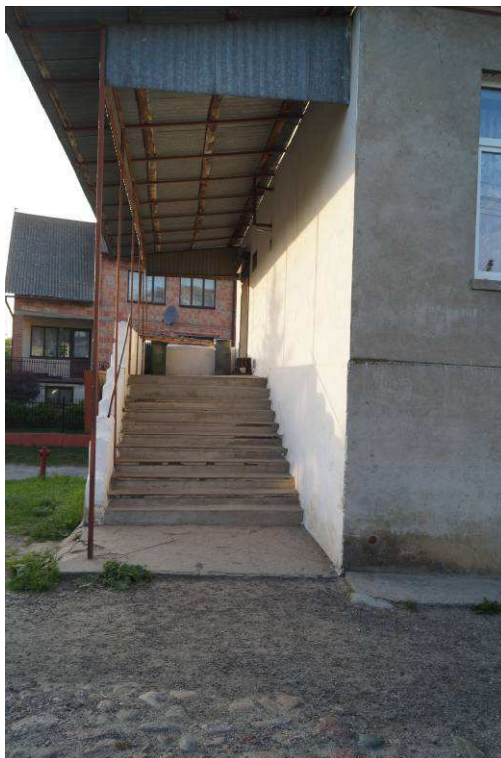
Schody zewnętrzne – wejście na piętro
