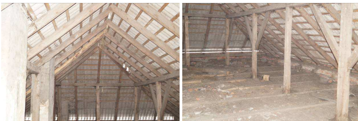
Konstrukcja więźby dachowej
